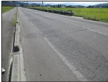
▲舗装損傷(ひび割れ・ポットホール)により走行性が低下した箇所
