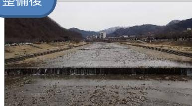
➢ 堆積した土砂を掘削することにより、流下断面が確保され、治水安全度が向上した状況
