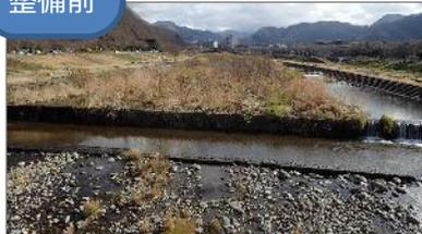
➢ 堆積した土砂により河積が阻害されている状況
