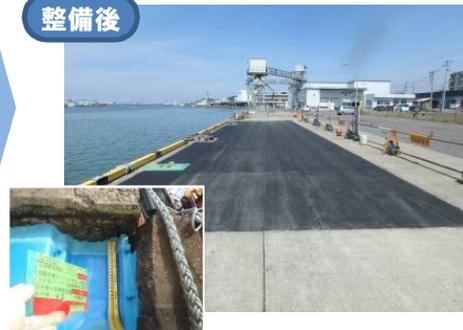
矢板の補修・防食、裏埋、舗装が完了し、利用制限が解除された。
