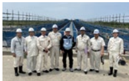
▲現地調査の様子
