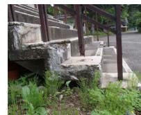
コンクリートの劣化と手摺腐食
