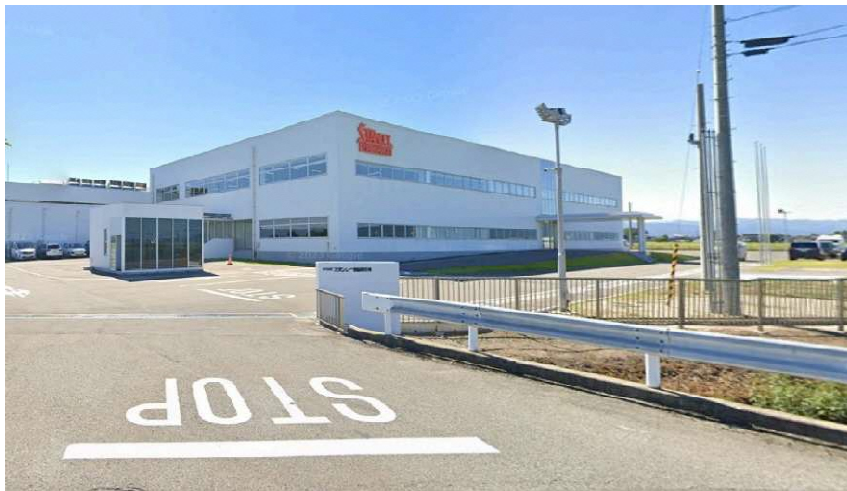
写真位置① 屋根設置対象建屋
