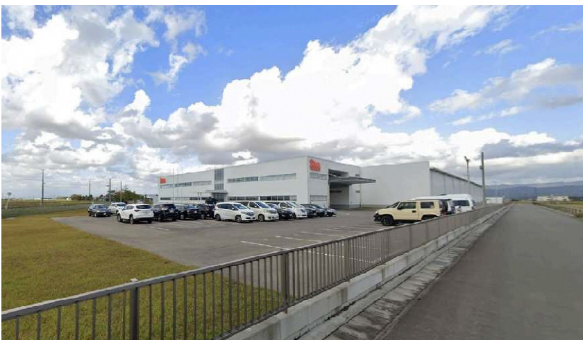
写真位置② 屋根設置対象建屋
