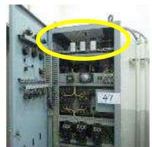
可変周波数電源装置に取り付けられた低圧コンデンサー
