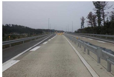
【Aから見た本件事故現場の状況】
