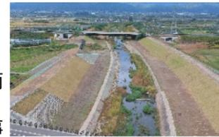
令和2年7月豪雨被災箇所への堤防復旧・高上げ工事
