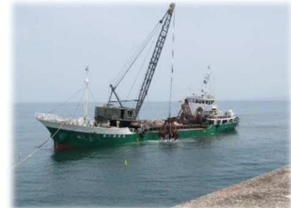
写真4: ガット船の基礎捨石投入状況
