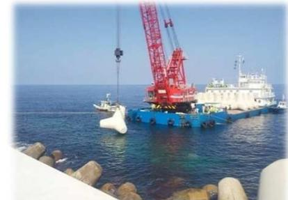
写真6: 消波ブロック据付状況
