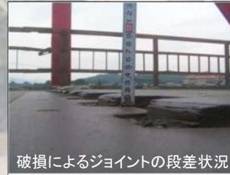
破損によるジョイントの段差状況
