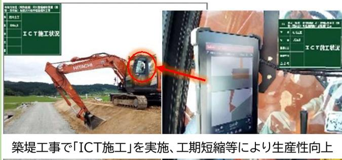
築堤工事で「ICT施工」を実施、工期短縮等により生産性向上
