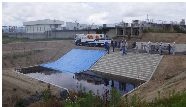
写真 2-2 排水ポンプ車の訓練状況 （山形浄化センター）
