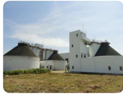
山形浄化センター 消化タンク
