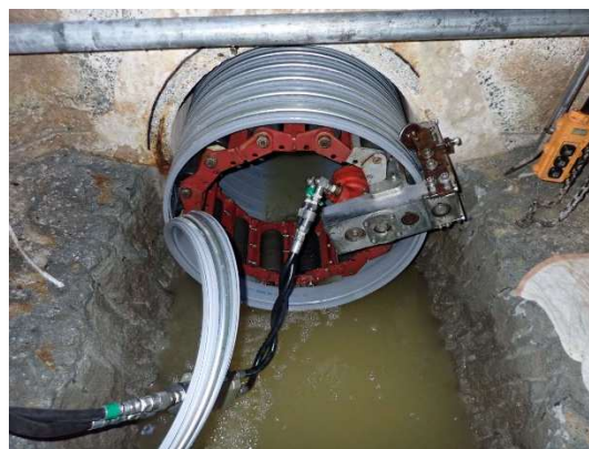
写真 5-1 対策工法のイメージ（更生工法（SPR-SE 工法））
