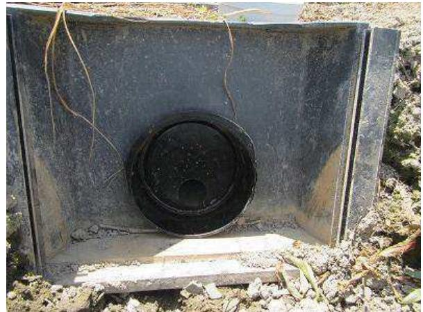
田んぼダム実施は場にて、その効果を検証するための現地説明会を行いました。水戻柵に排水制御板を設置したは場と、設置しないは場それぞれに水位計を設置し、排水量の違いを観測することで、その効果を検証するものです。
