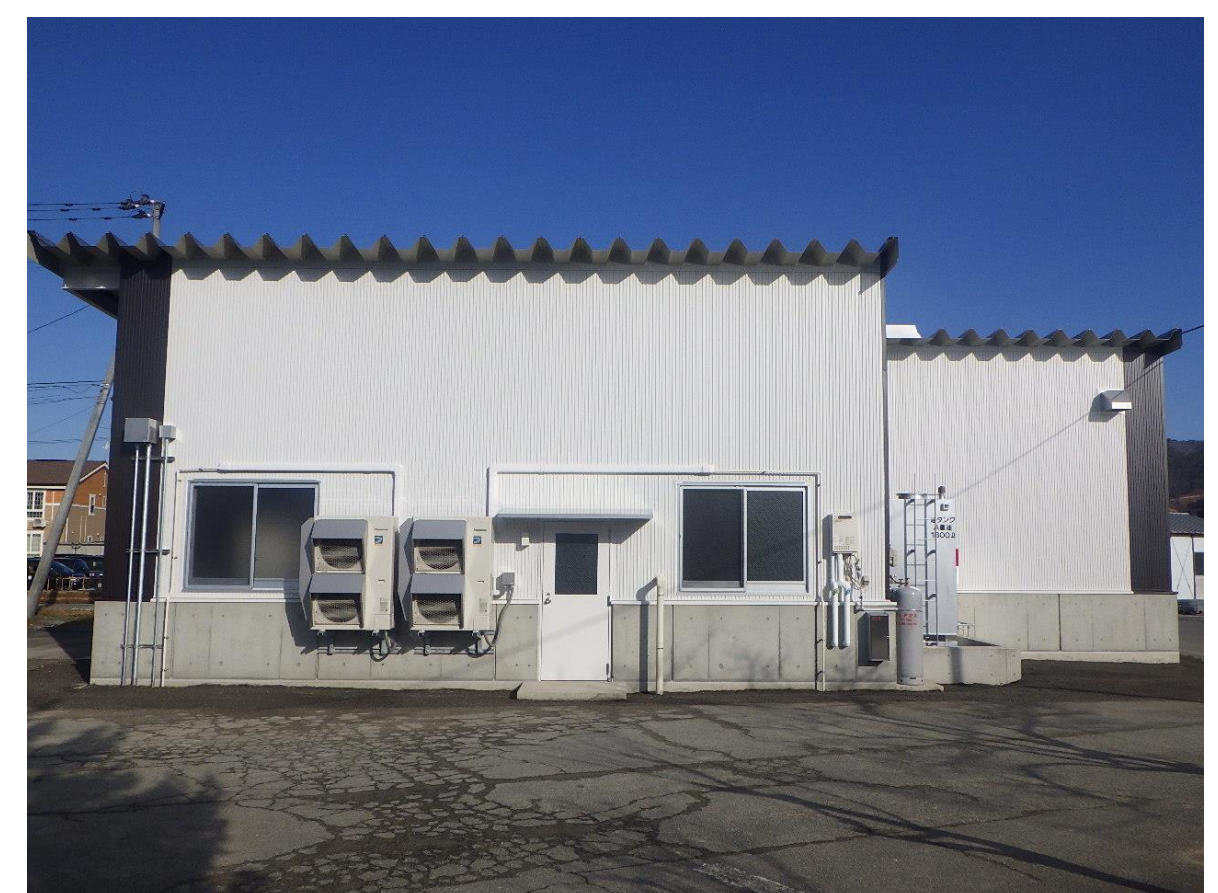
解剖棟(令和5年度完成)
