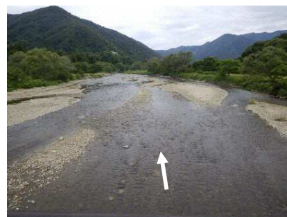
④最上白川合流点上流 (下白川橋)
