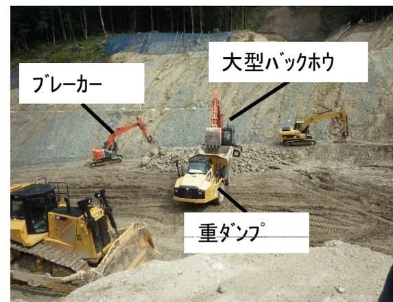
図 騒音測定時の稼働していた重機
