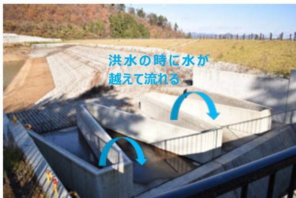
写真のようにジグザグの形状をした構造物で、水はこの構造物の上を越えて流れていく。限られた場所で水を多く流すには、水が越える長さを大きくする必要があるので、ジグザグにして長さを稼いでいる。
