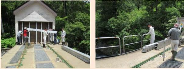
大鳥の施設管理は、池付近の雪解け後から始まる。雪囲いを撤去し、登山道にもなっている堰堤に手すりを設置。雪解けによって流れた流木の撤去や施設の点検を行う。
