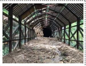
H30.8 月 陸羽西線における大雨による線路への土砂流入の状況
